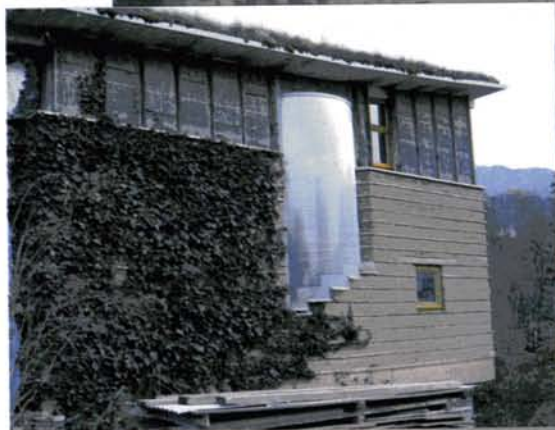
L'atelier di Martin Rauch, a Schlins in Austria, è un edificio dimostrativo delle sue diverse tecniche di costruzione. I muri perimetrali sono costruiti con la tecnica del "Pisé" (terra battuta in casseri). Il lato sud è chiuso da una struttura di legno e vetro tamponata con collettori solari e muri "Trombe" (termoaccumulatori).
