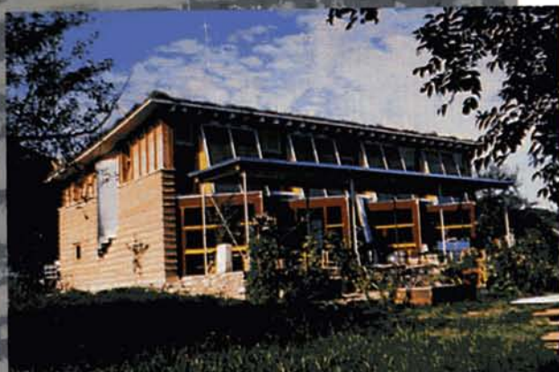
L'atelier di Martin Rauch, a Schlins in Austria, è un edificio dimostrativo delle sue diverse tecniche di costruzione. I muri perimetrali sono costruiti con la tecnica del "Pisé" (terra battuta in casseri). Il lato sud è chiuso da una struttura di legno e vetro tamponata con collettori solari e muri "Trombe" (termoaccumulatori).
